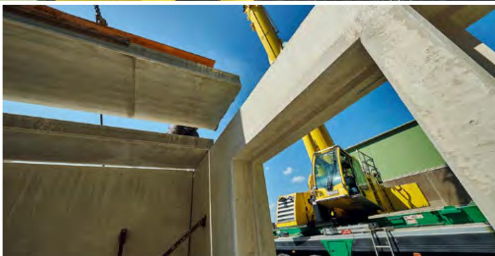
setzt Tump die Deckenteile auf die bereits stehenden Wandelemente. Das Bauteam kümmert sich um die zentimetergenaue Positionierung. Weil der Kranführer die Bauarbeiter von seiner Position aus nicht mehr sehen kann, sind sie ständig per Funk mit dem Oberwagen des Krans verbunden.
