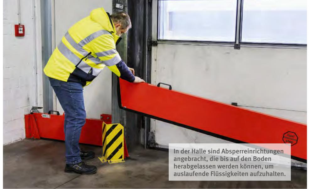
In der Halle sind Absperreinrichtungen angebracht, die bis auf den Boden herabgelassen werden können, um auslaufende Flüssigkeiten aufzuhalten.
